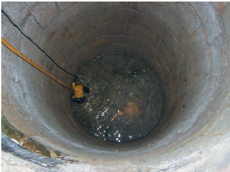
Fig. 10: Abpumpen des Nagy-Brunnens (Foto: G. HAJNAL, 2009). Drawdown at well Nagy (photo: G. HAJNAL, 2009).
